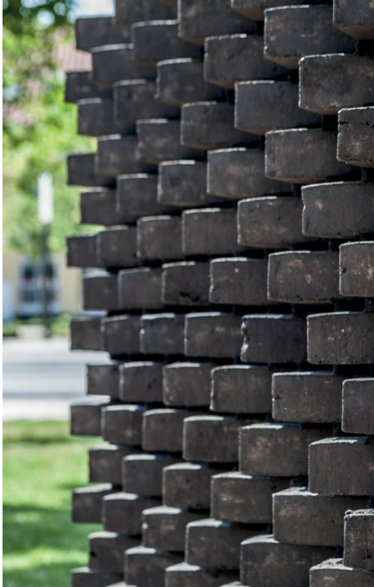
Thermal Forms 2 (2013): Murværkskomposition organiseret for at øge optaget af solenergi og muligheden for ventilering af interne rum. Projektet er skabt gennem nye simuleringsmetoder til at genererer arkitektonisk form. Projekt: Isak Worre Foged, støttet af COWI Fonden, Webers og Randers Tegl (Foto: Henrik Ehlers).
