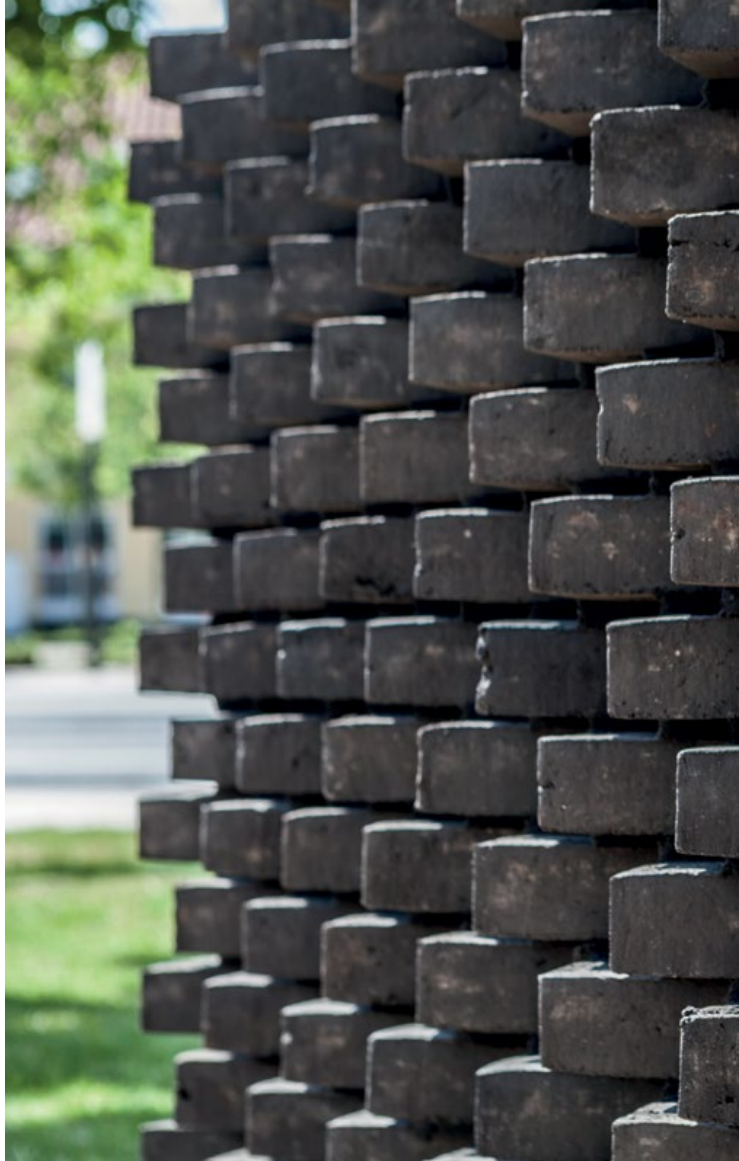
Thermal Forms 2 (2013): Murværkskomposition organiseret for at øge optaget af solenergi og muligheden for ventilering af interne rum. Projektet er skabt gennem nye simuleringsmetoder til at genererer arkitektonisk form. Projekt: Isak Worre Foged, støttet af COWI Fonden, Webers og Randers Tegl (Foto: Henrik Ehlers).
