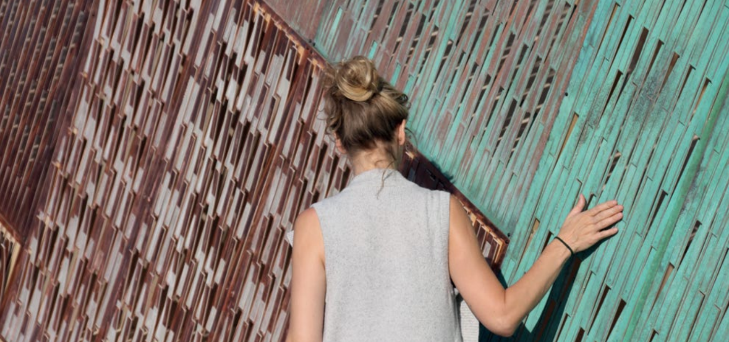
Sense 3 (2014): Responsiv bygningsfacade baseret på nyudviklede kompositkonstruktioner der regulerer det indre termiske miljø drevet af det ydre termiske miljø. Projekt: Isak Worre Foged og Anke Pasold (AREA), støttet af Realdania (Foto: Isak Worre Foged).
