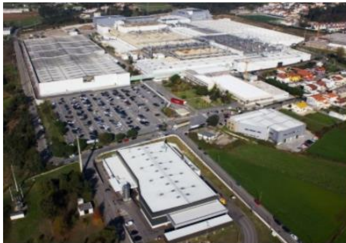
Figura 40: Vista aérea da CMIP (Mabor, 2016)
