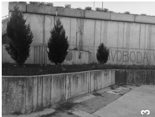
SLIKA 11: Betonska korita [vir: lastna slika]
