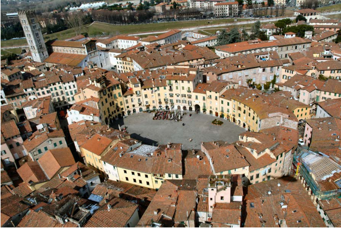
FIG. 130 Reuse of the site of the Roman amphitheater in Lucca, Piazza dell'Anfiteatro
