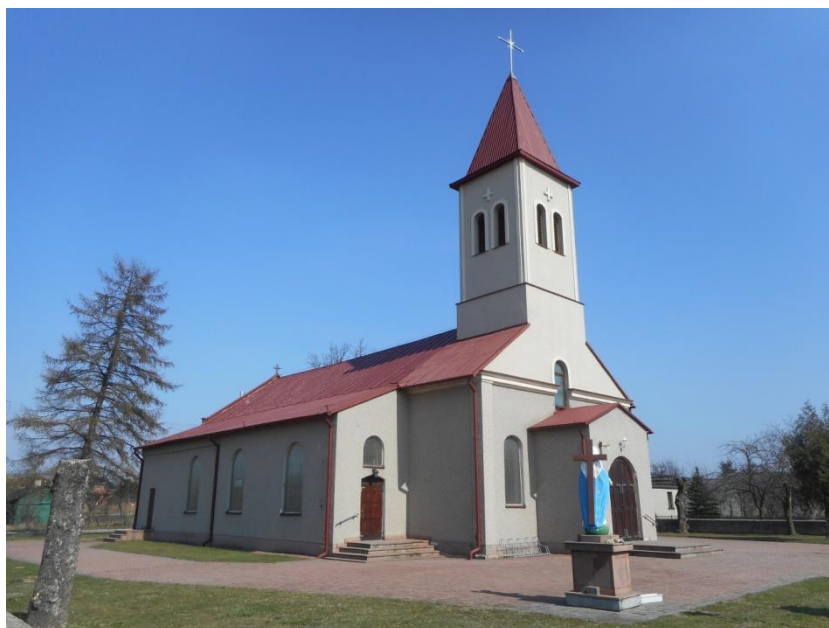
Il. 9. Kościół Parafii Najświętszego Serca Pana Jezusa w Woli Krzysztoporskiej. Marzec 2017 r. Fot. S. Latocha. Parafia powstała w 1951 roku, lecz sam kościół wolanie zbudowali w latach 1935-1937. W latach 60. i 90. dobudowano boczne kaplice, nawy oraz krużgocę. Odpusty przypadają na: uroczystość Najświętszego Serca Pana Jezusa oraz wspomnienie bł. Czesława (20 lipca). Opieką pastoralną Parafii objęte są miejscowe przedszkole oraz zespół szkolno-gimnazjalny.
