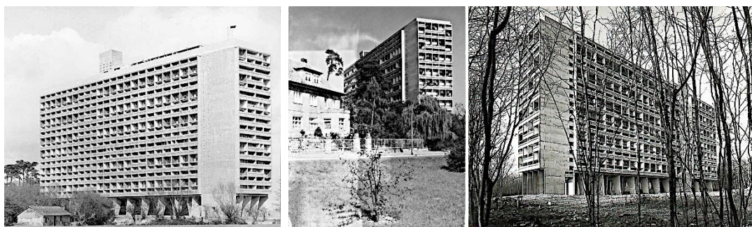
Figura 54 – Le Corbusier (1952) Unité d'habitation , Rezé.
