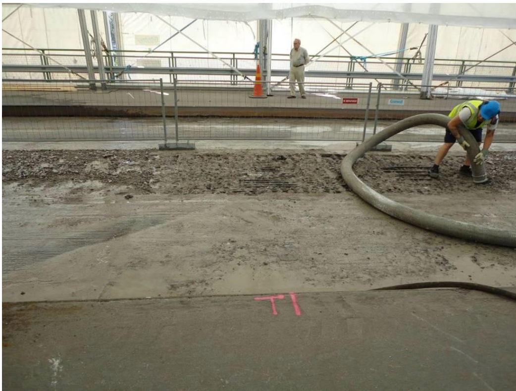
KUVA 5. Piikatur betonipinnan puhdistaminen (Liikennevirasto 2011, 10.)
