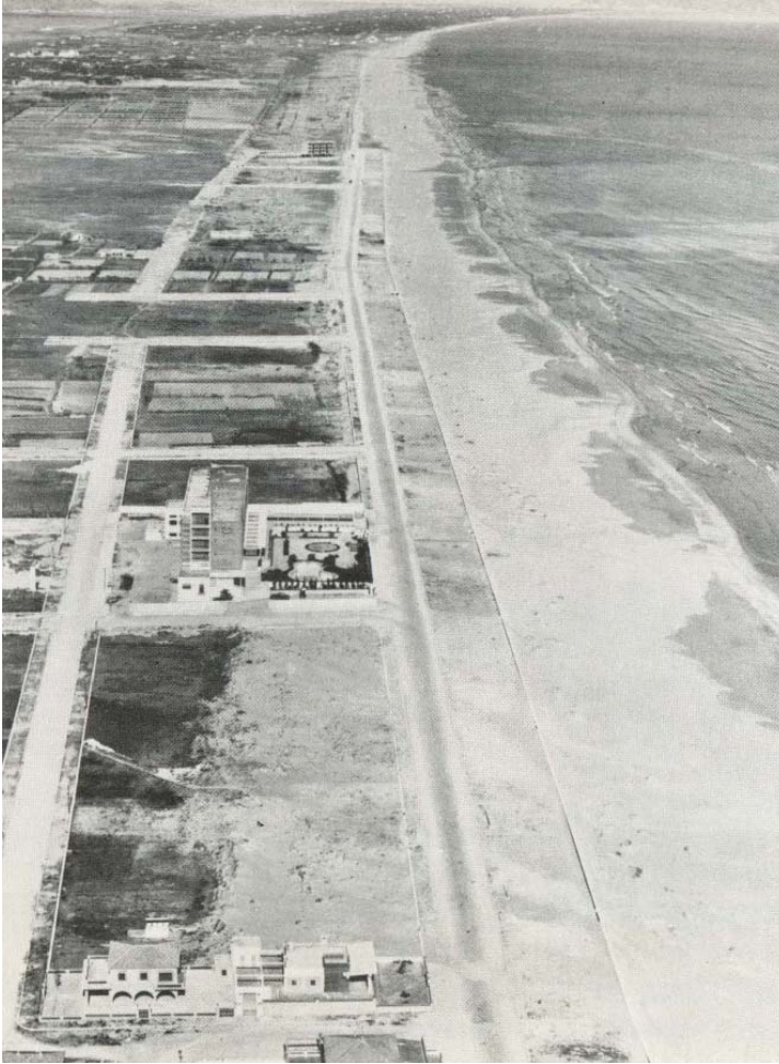
Imagen 44: Urbanización de la Playa de Gandia. Hotel Bayren (hacia 1959)
