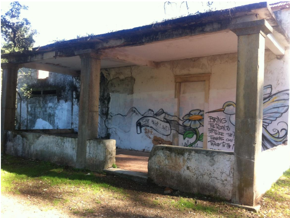
Figura 4.12- Casa abandonada que poderia ser o Centro de Interpretação (Fonte: João Varela)
