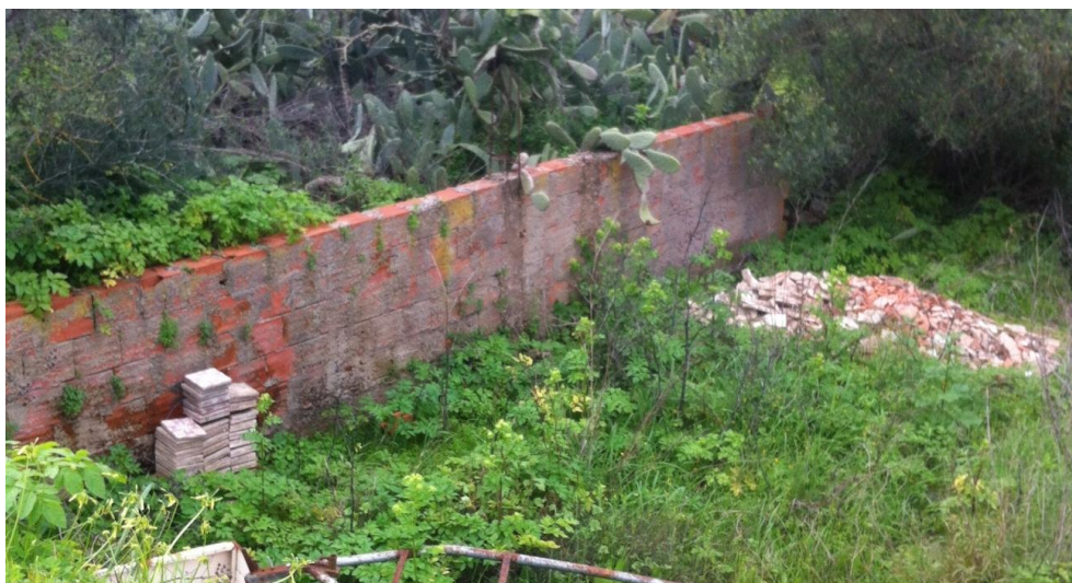
Anexo 10- Muro em cima da barragem do Álamo (Fonte: João Varela)
