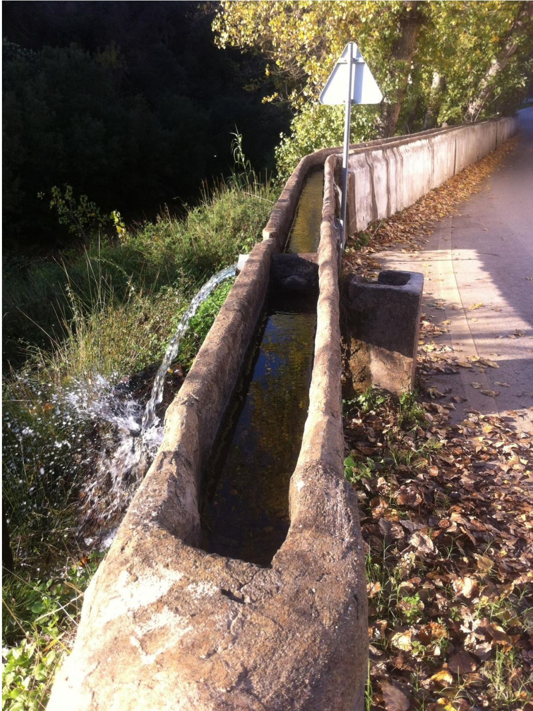
Anexo 17- Levada de água (Fonte: João Varela)
