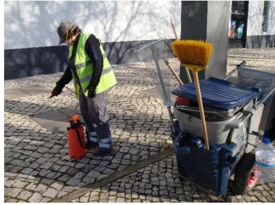
Figura 5.3– Aplicação de herbicida, com pulverizador dorsal de 5L, em Portimão
