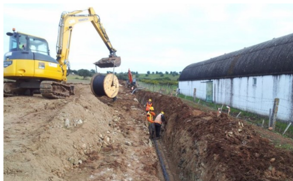
Figura 53 - Equipamento de medida da resistência de isolamento. Instalação do monocabo em vala.
