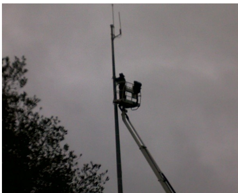
Figura 51 – Instalação de unidades concentradoras
