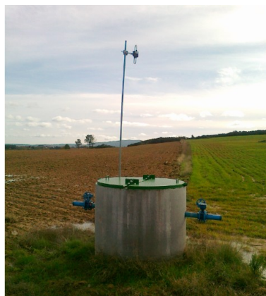
Figura 8 - Hidrante em aproveitamentos hidroagrícolas
