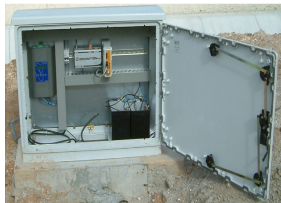
Figura 51 – Instalação de unidades concentradoras
