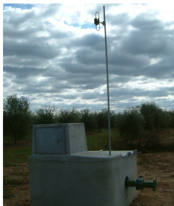
Figura 8 - Hidrante em aproveitamentos hidroagrícolas
