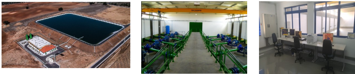
Figura 19 – Estação elevatória de Brinches
