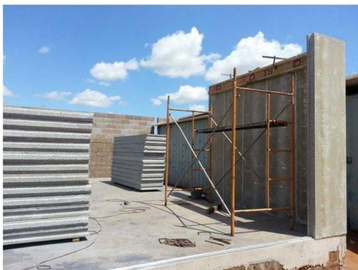
Figura 2.7 – Construção com recurso ao painel sandwiche de betão (DNN, 2016)
