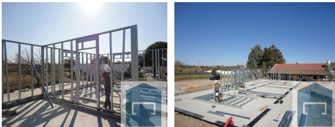
Figura 2.3 – Exemplos de conceção de estrutura em Light Steel Framing (LSF) recorrendo ao método peça por peça (Futureng, 2003-2016)
