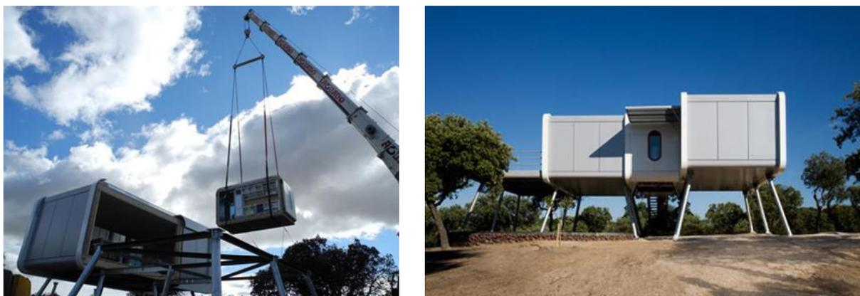
Figura 2.14 - Implantação de módulo prefabricado da Spaceship Home (esquerda) e aspecto geral da moradia prefabricada concluída (direita) (Dezeen, 2011)
