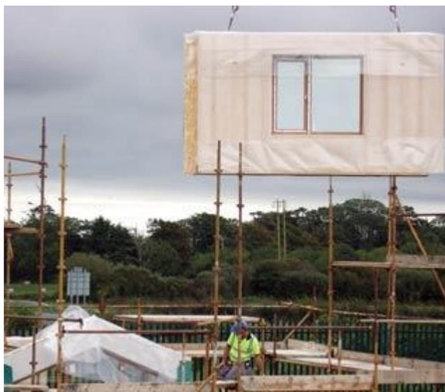
Figura 2.5 – Painel estrutural de parede revestido a madeira e com caixilharia instalada (Costa, 2013)
