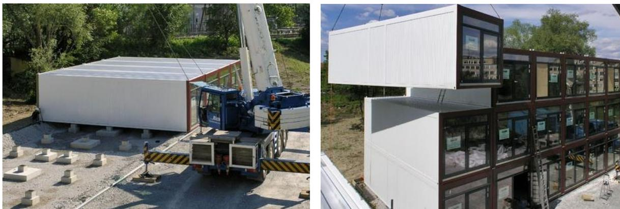
Figura 2.6 – Montagem de módulos prefabricados: a) Ligação às fundações; b) Ligação entre módulos (Costa, 2013)
