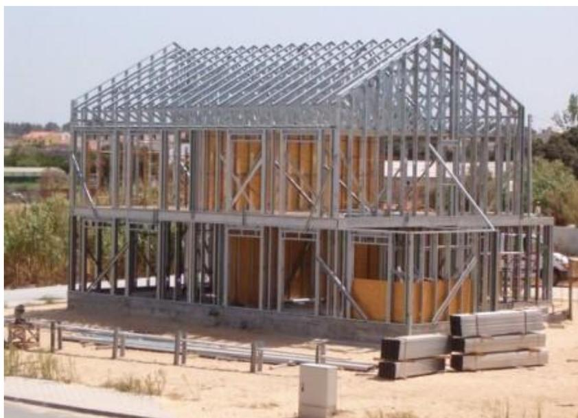
Figura 3.3 – Estrutura metálica antes da aplicação do revestimento estrutural. (Gaspar, 2013).
