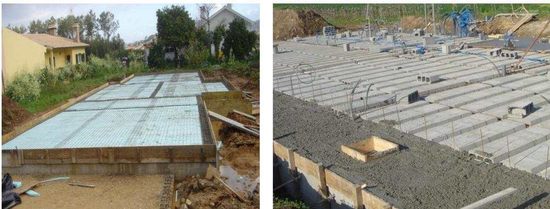
Figura 3.2 – Ensoleiramento geral e laje aligeirada com caixa-de-ar (Silvestre et al, 2013)
