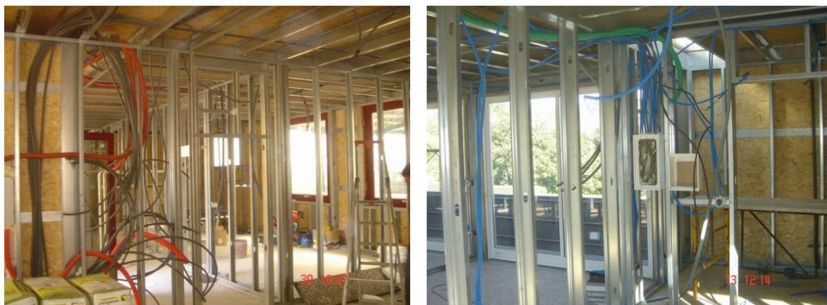
Figura 3.6 – A utilização de perfis com perfuração permite a passagem de tubagens (Silvestre et al, 2013).
