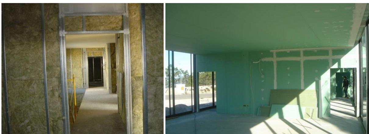
Figura 3.7 – Isolamento de paredes em lã de rocha (esquerda) e gesso cartonado como revestimento exterior (direita).
