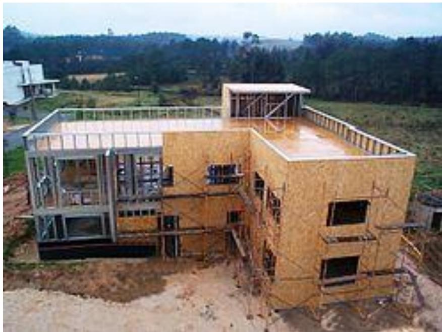
Figura 3.4 – Estrutura metálica parcialmente revestida com placas estruturais OSB. (Gaspar, 2013).
