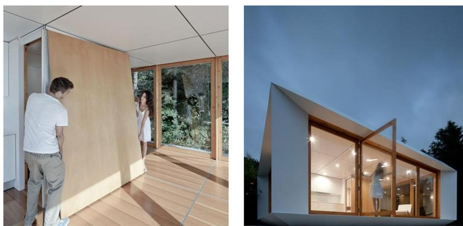
Figura 2.12 - Divisórias amovíveis (esquerda) e especto geral da moradia prefabricada (direita) (Dezeen, 2011)
