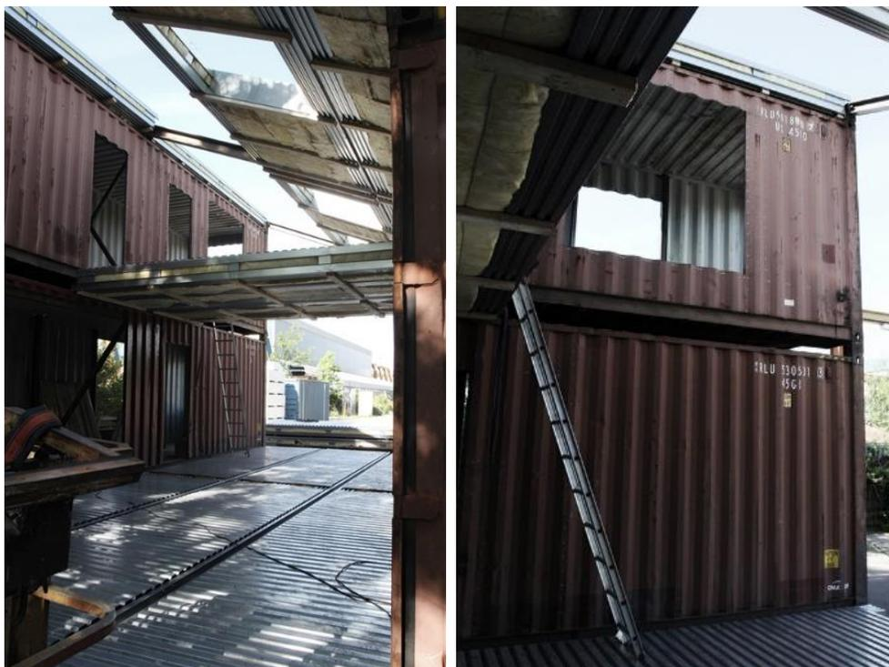
Figura 2.9 – Obra construída com recurso a contentores marítimos reciclados - fase de obra (Engenharia Civil Na Internet, 2013)
