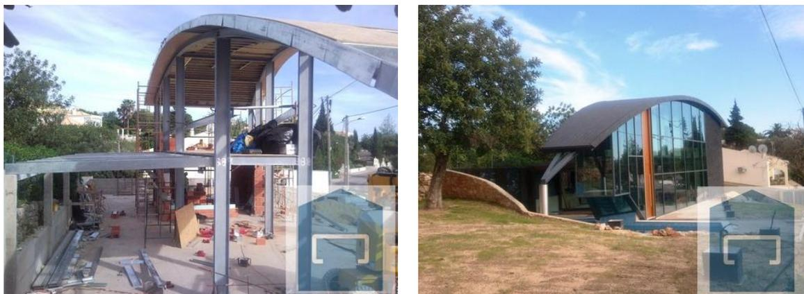
Figura 2.11 – Moradia construída em LSF em associação com o em aço laminado. Fase de obra (esquerda) e moradia concluída (direita) (Futureng, 2003-2016)
