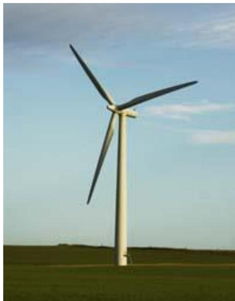
Figura 3.16 - Turbina eólica de eixo horizontal, com três pás (Tubines Info, 2011).
