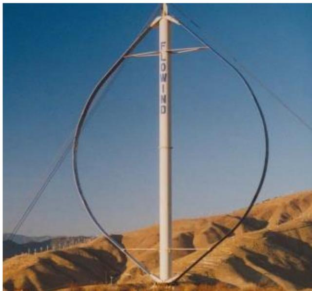
Figura 3.17 - Turbina de eixo vertical do tipo Darrieus (Maia, 2010).
