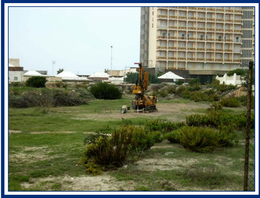
EMPLAZAMIENTO DE LA MÁQUINA EN EL SONDEO S-1
