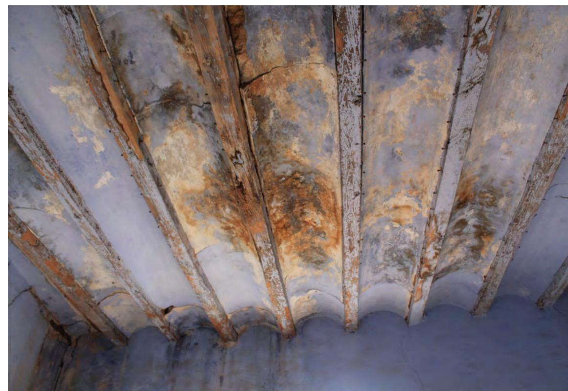
Filtraciones de agua en cubierta de las cámaras de la planta segunda, con daños importantes en vigas de madera y revoltones. Fotografía: María José Berenguer
