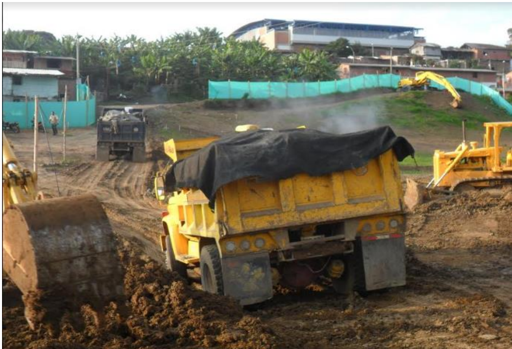
Figura 5: retroexcavadoras Komatsu PC200
