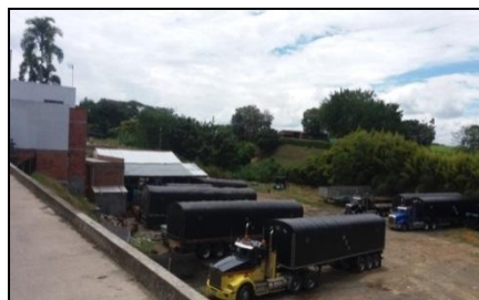
B. Zona de mantenimiento y parqueadero de camiones, en E.D.S
