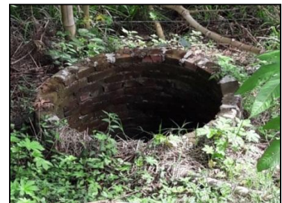
F. Aljibe sin cubierta
