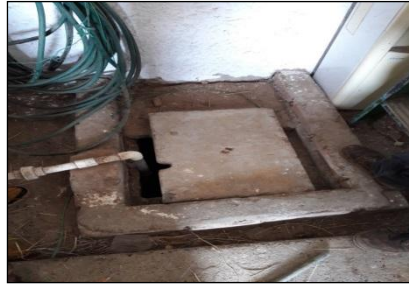
H. Aljibe con cubierta inadecuada
