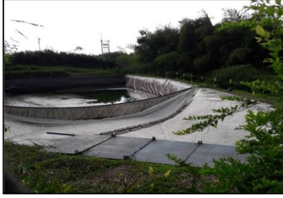
H. Laguna de oxidación
