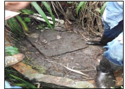
I. Aljibe inactivo por colapso del terreno
