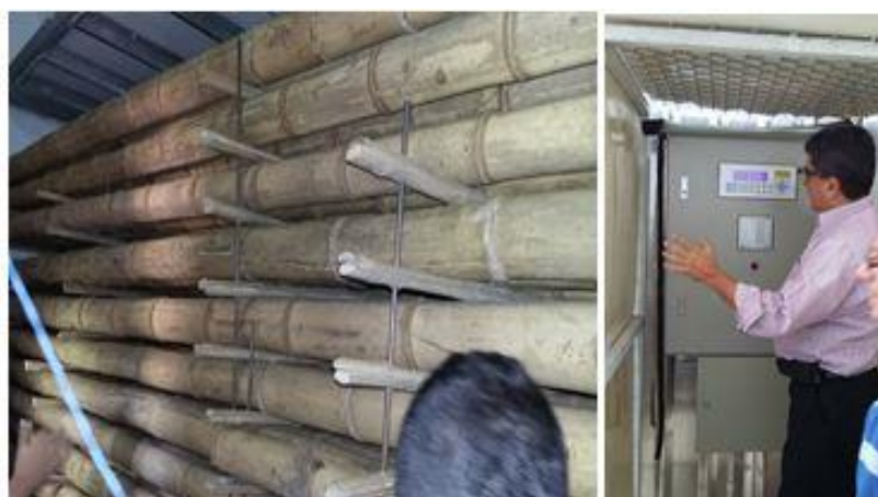
Figura 5: Cámara de secado
