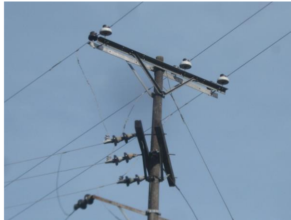
Figura 9. Cambio de crucetas programado como mantenimiento preventivo
