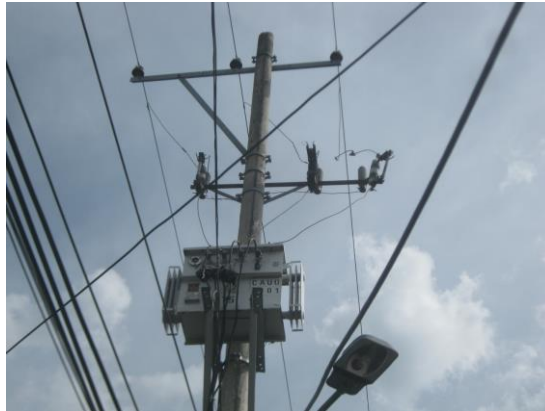
Figura 46. Imágenes mantenimiento correctivo (pararrayo estallado)
