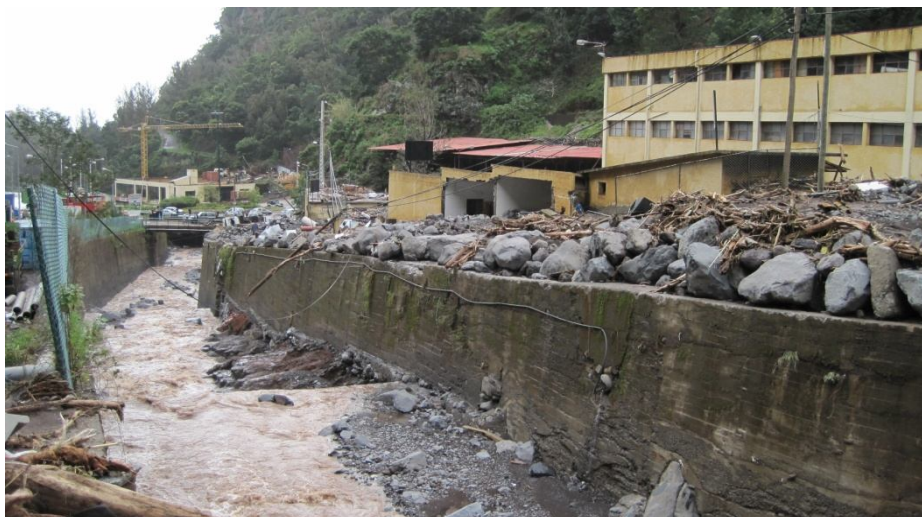
Figura 20 - Deposição de material sólido na Fundoa [Fonte: Jorge Freitas – Secretaria Regional do Equipamento Social]
