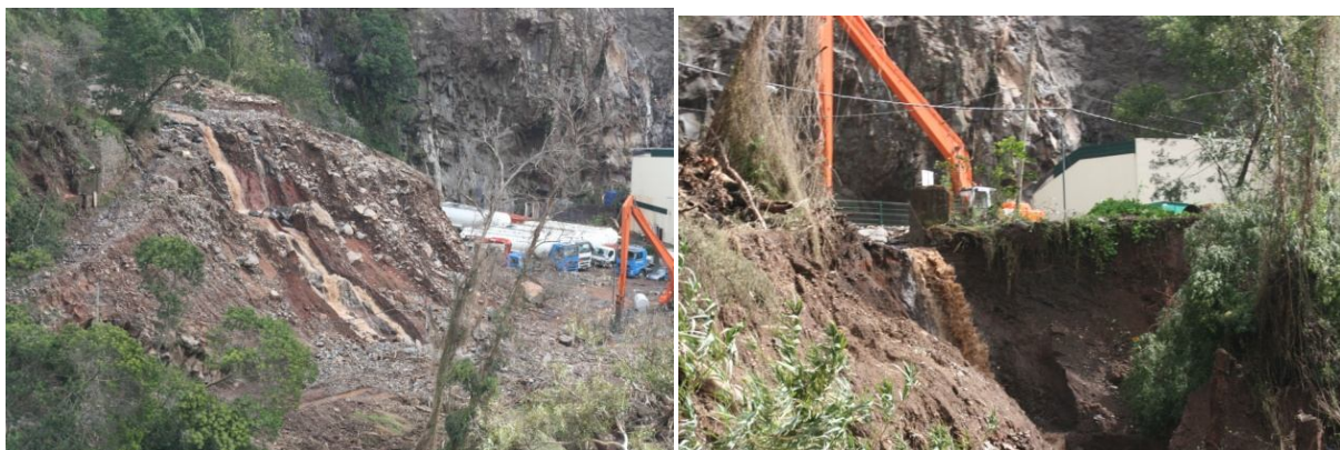
Figura 50 - Deposição de material na Estrada Comandante Camacho de Freitas [Fonte: Desconhecido]
