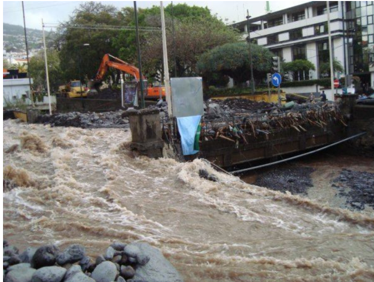
Figura 23 - Ribeira de João Gomes no centro do Funchal [Fonte: Desconhecido]
