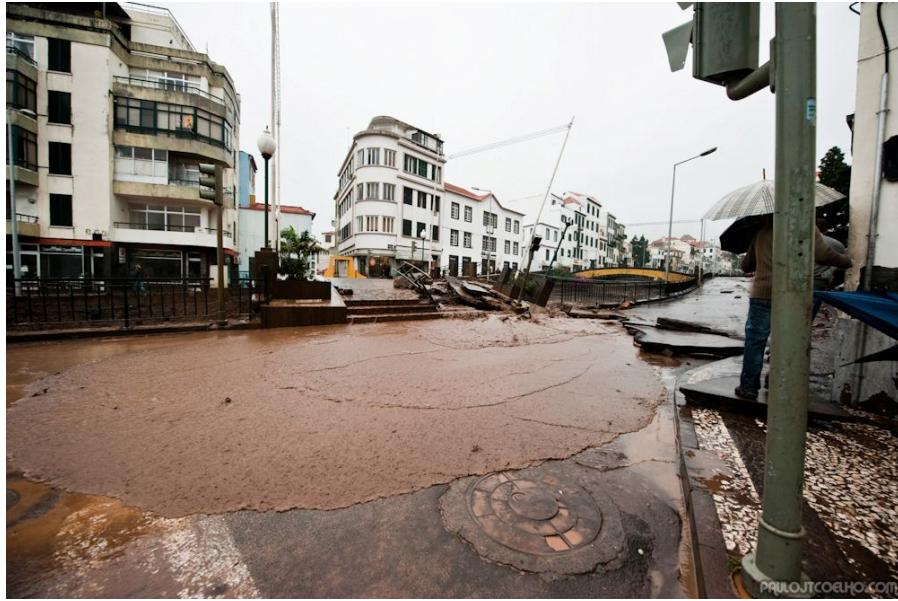
Figura 45 - Transvasamento na Ponte do Cidrão [Fonte: Paulo J. T. Coelho]
