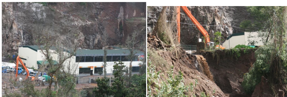
Figura 58 - Estragos no edifício da Socipamo e no afluente [Fonte: Desconhecido]
