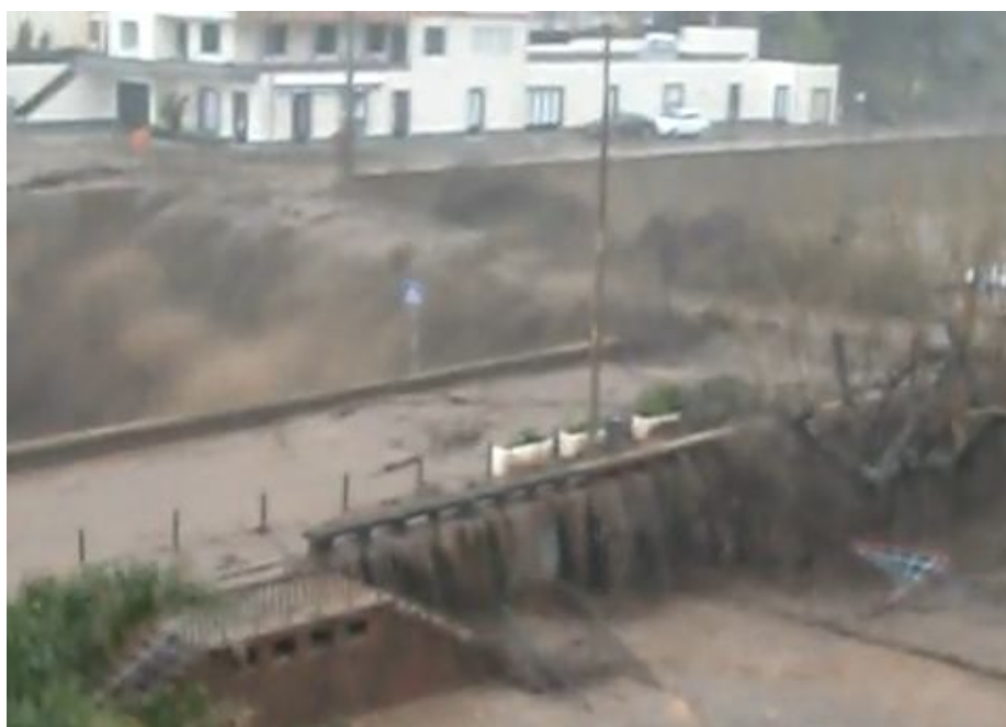
Figura 27 - Ponte do centro da Ribeira Brava que ficou danificada [Fonte: http://www.youtube.com/watch?v=N1ZAV2PSVu0&feature=related , 11/10/10]
