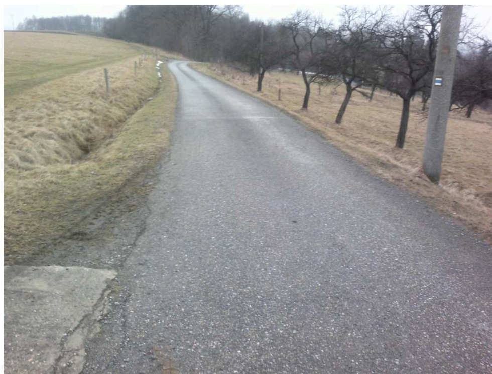
Obr. 26 Místní obslužná komunikace „ulice Na Zadkách“ (A i B)
