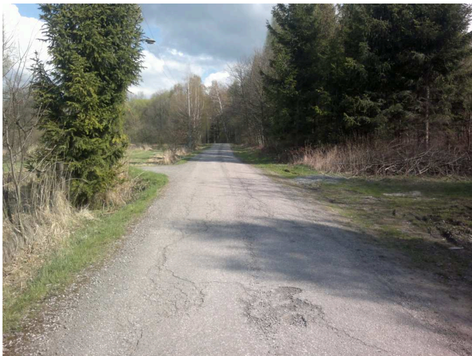
Obr. 24 Místní obslužná komunikace „ulice Na Zadkách“ (A i B)
