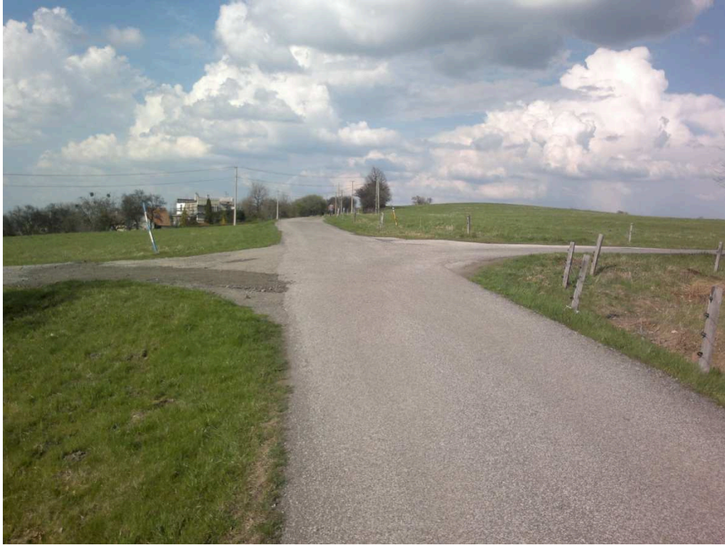
Obr. 27 Křížení Ulice na Zadkách s účelovou komunikací (A i B)
