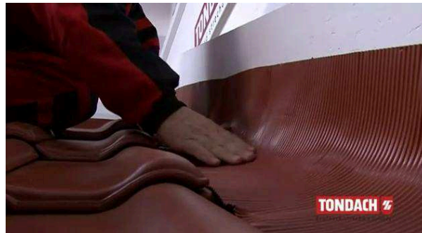
Obr. napojení na zeď hliníkovým pásem [36]
