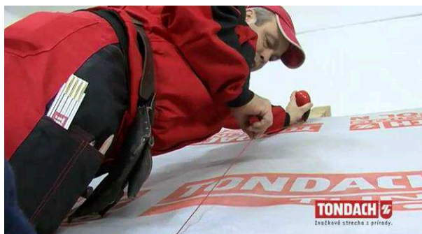
Obr. Vyznačení středu krokví pomocí šňůrovačky [33]
