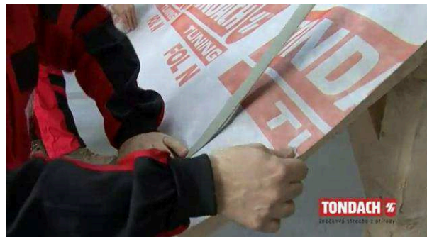
Obr. lepení těsnící pásky TONDACH TUNING 50 pod kontratatě [33]
