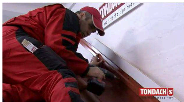
Obr. montáž těsnící lišty [36]
