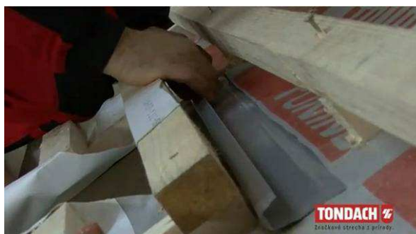
Obr. Odvodňovací žlabek nad střešním oknem [CH]
