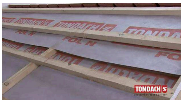
Obr. Kladení pojistné hydroizolace u hřebene střechy [37]
