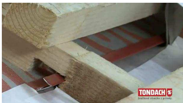
Obr. Odvodňovací žlab u zlomu pultového vikýře [39]
