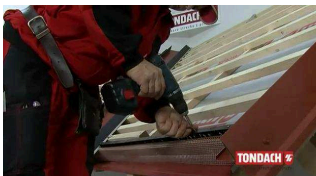
Obr. Osazování ochranné větrací mřížky [33]
