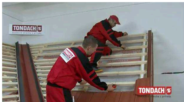
Obr. Nanesení krycí šířky pomocí šňůrovačky [35]
