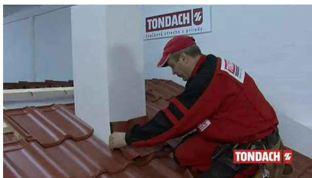
Obr. Úprava těsnícího pásu [39]
