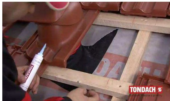
Obr. Použití těsnícího tmele [41]
