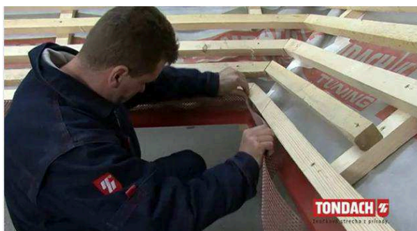
Obr. Přichycení hliníkového ochranného pásu" [33]
