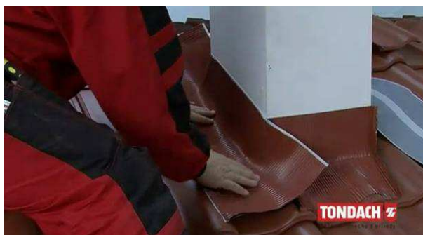
Obr. Úprava bočního těsnícího pásu [39]
