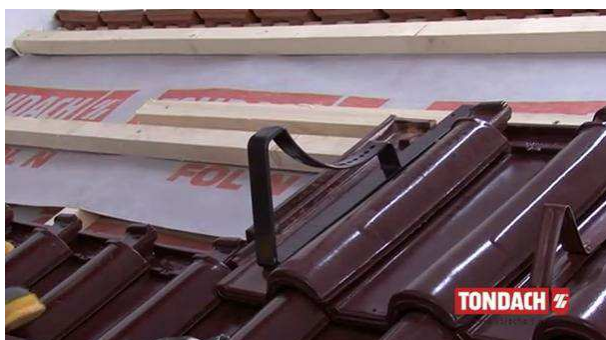
Obr. Montáž držáků stoupacího kompletu [40]
