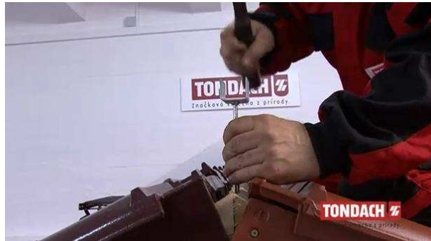
Obr. Montáž hřebenové latě [37]
