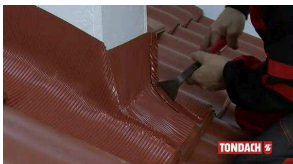
Obr. Zahnutí těsnících pásů [39]
