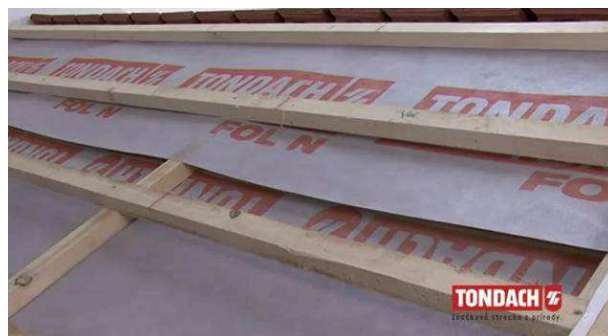
Obr. Kladení pojistné hydroizolace u hřebene střechy [37]
