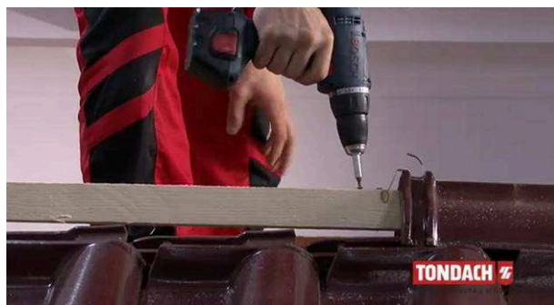
Obr. Uchycení hřebenáče pomocí příchytky [37]
