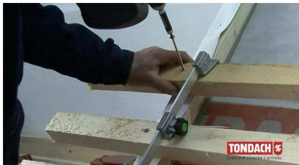
Obr. Nanášení vzdálenosti latí pomocí nářadí „koník“ [34]
