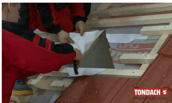
Obr. Úprava fólie před montáží střešního okna [CH]
