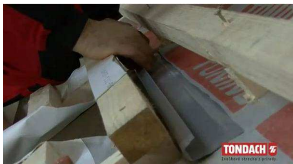
Obr. Odvodňovací žlábek nad střešním oknem [CH]
