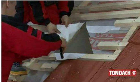
Obr. Úprava fólie před montáží střešního okna [CH]
