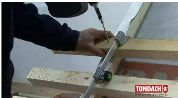
Obr. Nanášení vzdálenosti latí pomocí nářadí „koník“ [34]
