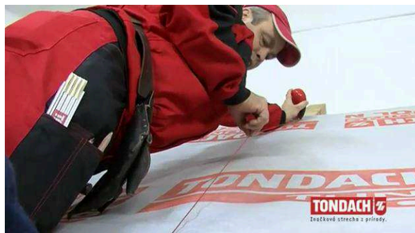
Obr. Vyznačení středu krokví pomocí šňůrovačky [33]
