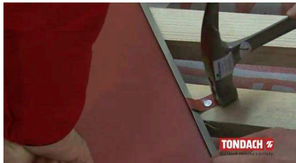
Obr. Správné přichycení úžlabí přichytkami [38]
