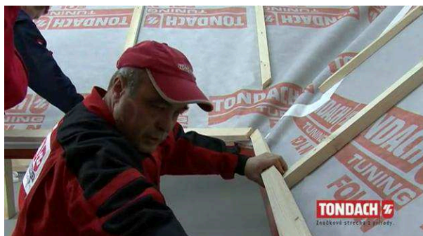
Obr. Kladení okapní latě [33]
