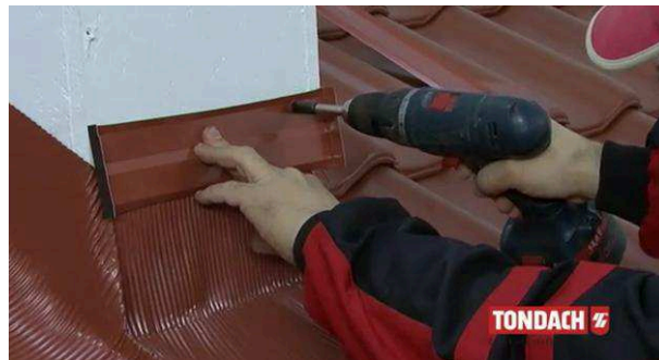
Obr. Překrytí těsnícího pásu pomocí hliníkové lišty [39]
