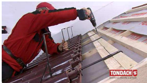
Obr. Montáž držáků pro sněhovou mříž [42]
