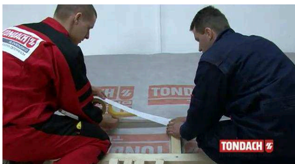
Obr. Kladení pojistné hydroizolace [33]
