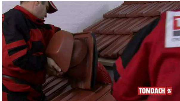
Obr. Usazení prostupového kompletu [41]
