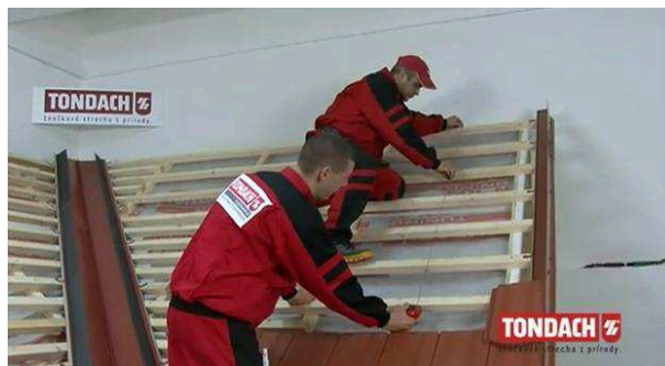
Obr. Nanesení krycí šířky pomocí šňůrovačky [35]
