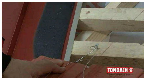
Obr. samolepicí těsnící pás a přichytka malých průřezů tašek drátem [38]
