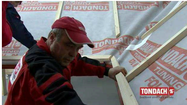
Obr. Kladení okapní latě [33]
