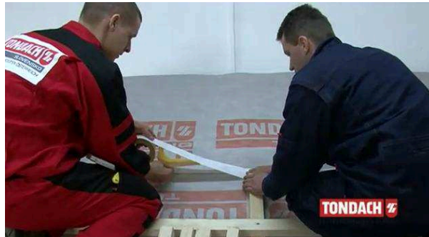
Obr. Kladení pojistné hydroizolace [33]
