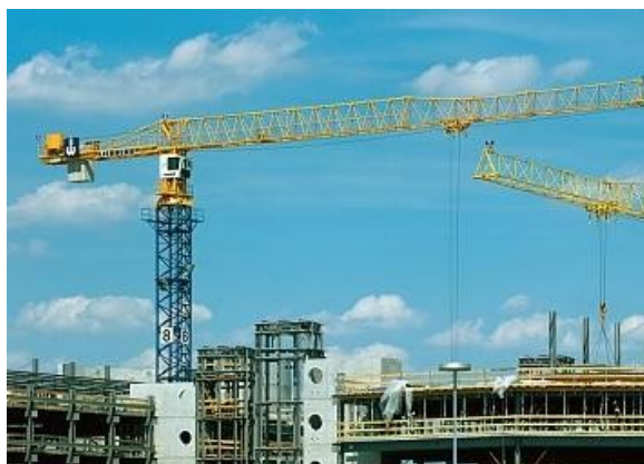
Obr. 1 - Věžový jeřáb Liebherr
