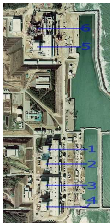
Obr. 1.8 Jaderná elektrárna Fukušima 2[8]
