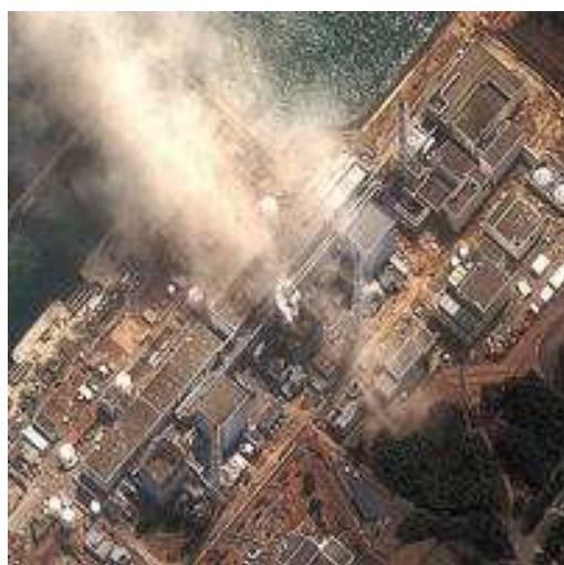
Obr. 1.7 Jaderná elektrárna Fukušima[8]
