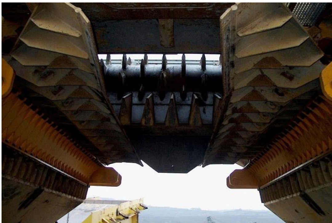
Obrázek 15 – Pohled ze spodu na příčně uložené rotory Tangenciálního drtiče skřívky
