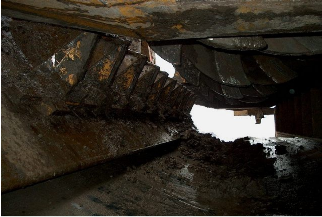
Obrázek 25 – Pohled na zuby rotoru a protistěny se spodu z dopravního pásma kolesového výložníku.
