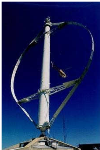
Obr. 1.14:Darrierův rotor [19]
