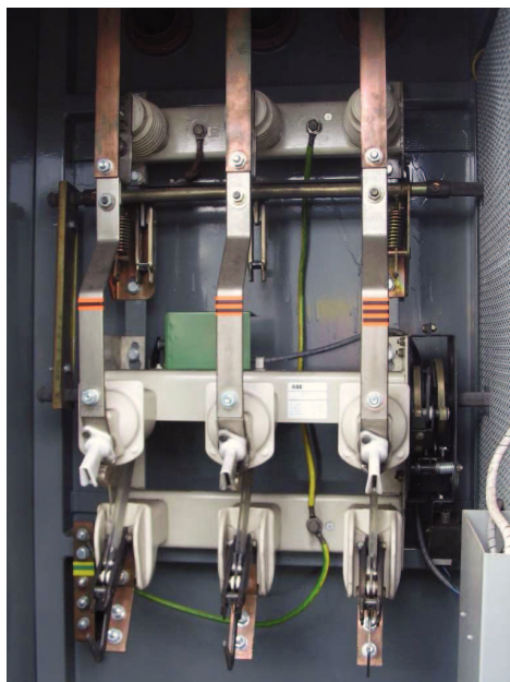
Obrázek 13: Odpínač uvnitř kiosku včetně zkratovacího mechanismu
