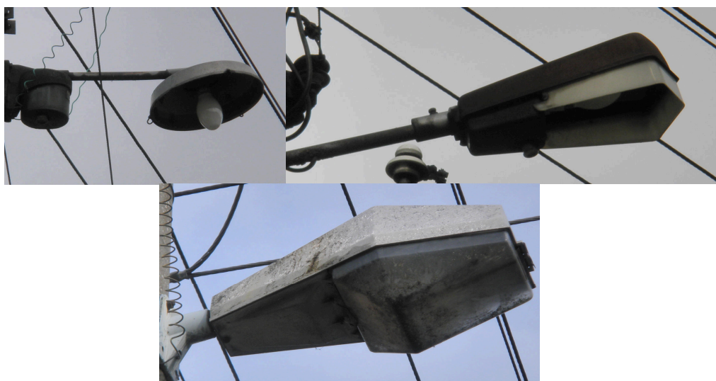
Obrázek 11 příklad zastaralých svítidel VO v obci Metylovice
