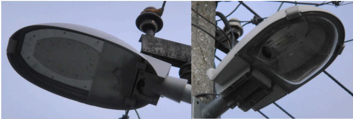
Obrázek 12 příklad svítidla nového typu VO v obci Metylovice (Zeus, Philips Malaga)
