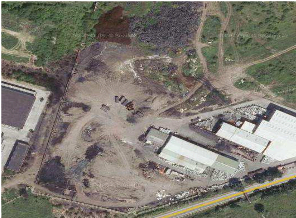
Obrázek č. 7: Areál firmy GRG Investment a.s. v Tušimicích po požáru. [24]
