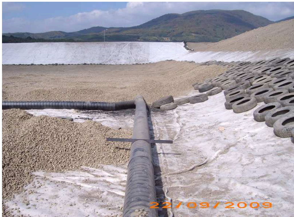
Obrázek č. 3: Drenážní systém a ochrana těsnění skládky ve Vysoké Peci. [25]
