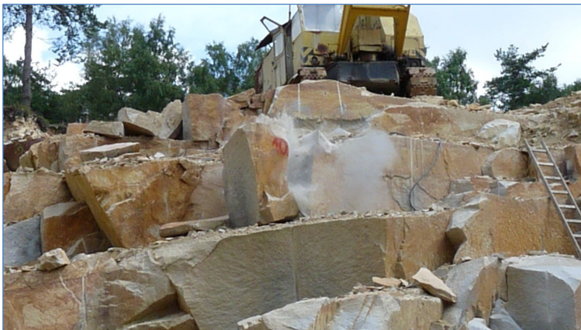
Obrázek 22: Rozpojení bloku č.10 - dělená nálož ČPD.
