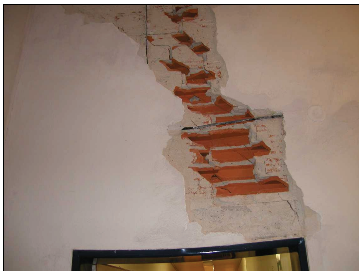
Obr. 2: Pohled na rozdrcené zdivo příčky
