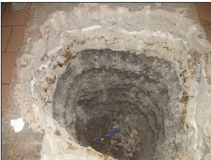
Obr. 7: Kopaná sonda uvnitř objektu pro odběr vzorků
