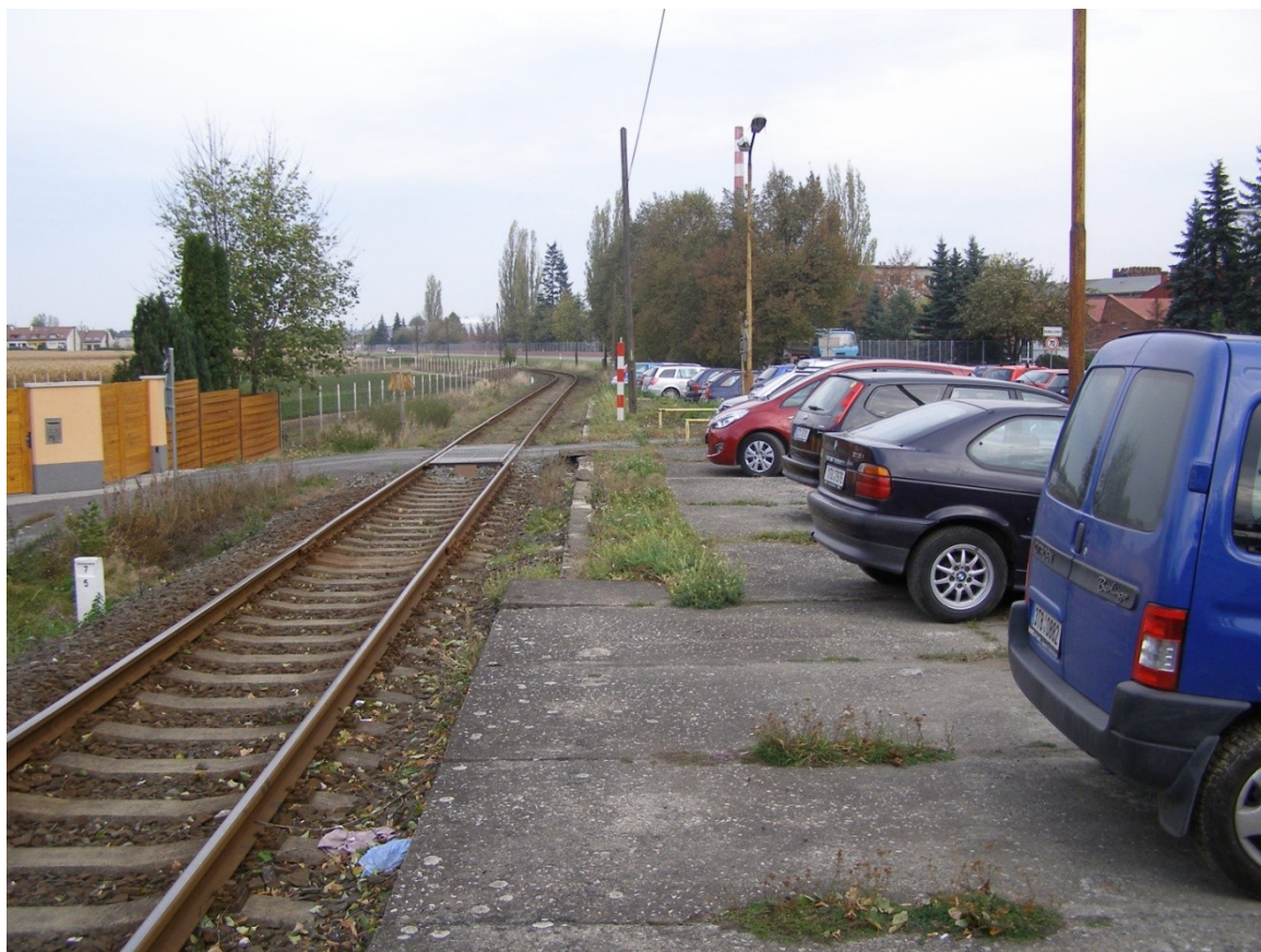
Pohled na nástupiště ve směru na Opavu
