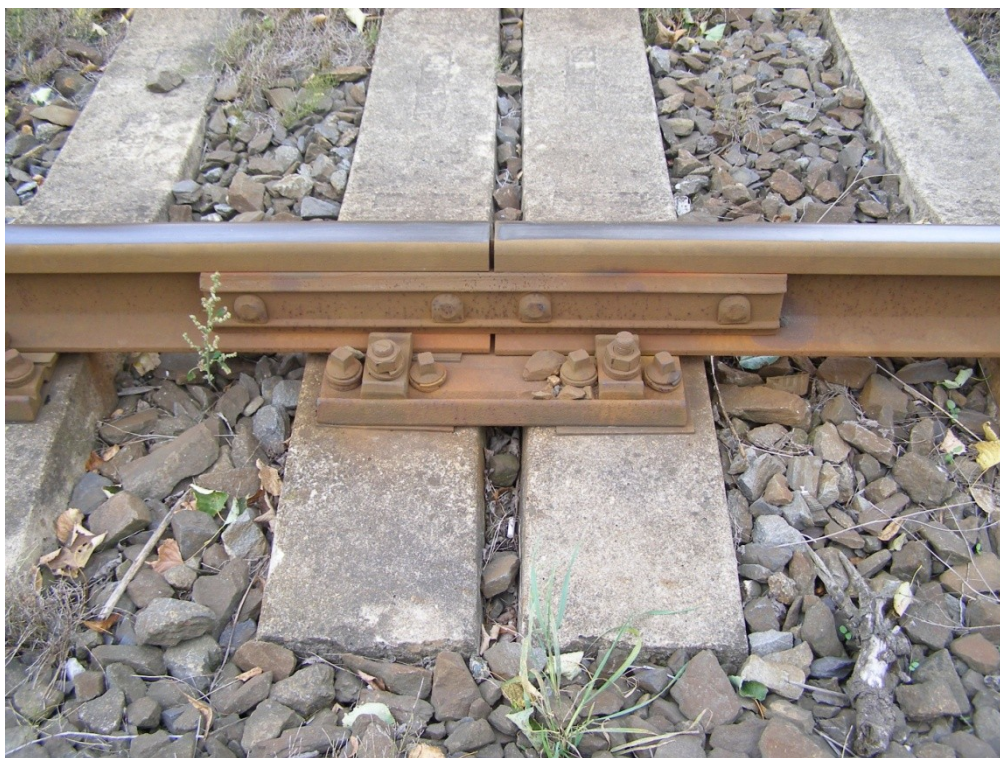
Obr. 11 Dokumentace stavu kolejového svršku
