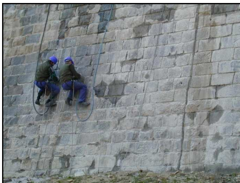
Obr. 7. Injektování dutin v hrázi přes injektážní vrty [38]
