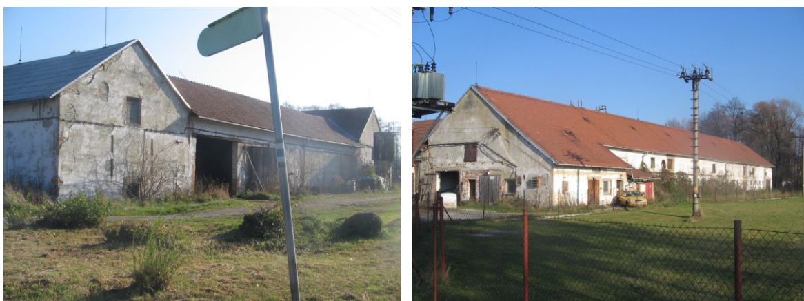
Obr 10, 11. Objekt stávajícího kravína
