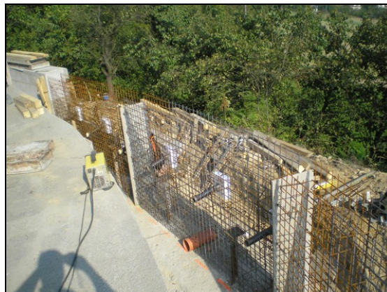
Obr. 3: Armatura včetně průchodek pro kotvy a drenážní potrubí
