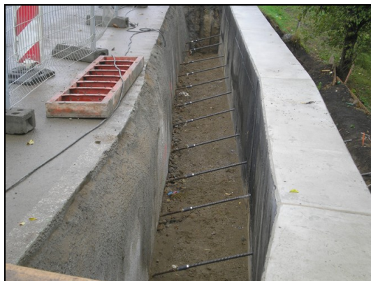
Obr. 4: Zemní kotvy TITAN 30/16
