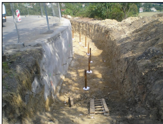
Obr. 2: Mikropiloty Ø 89/10 mm
