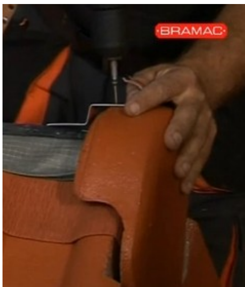
Obr. 4.7 – Přichycení uzávěry hřebene [6]
