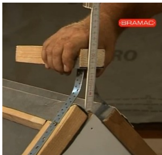
Obr. 4.5 – Poloha držáku hřebenové latě [6]
