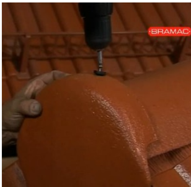
Obr. 4.9 – Přichycení koncové uzávěry [6]
