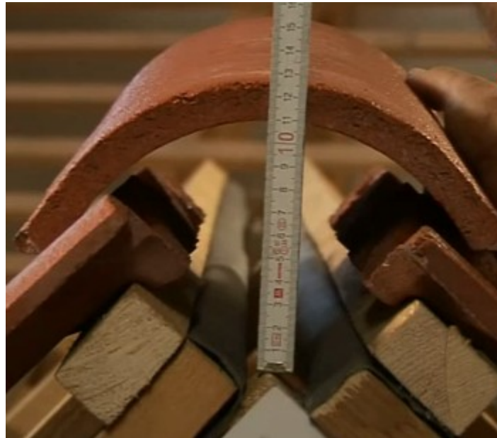
Obr. 4.4 – Zaměření polohy hřebenové latě [6]
