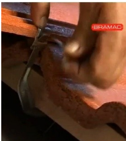
Obr. 4.3 Uchycení krajních tašek univerzální příchytkou [6]
