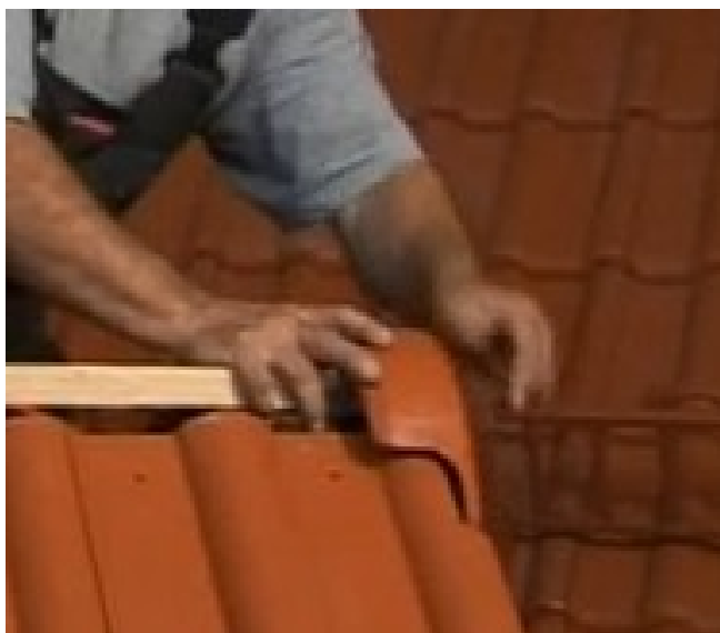
Obr. 4.6 – Konečná poloha hřebenové latě dle uzávěry hřebene [6]
