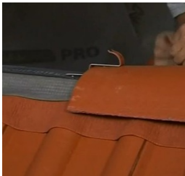
Obr. 4.8 – Přichycení hřebenáče příchytkou [6]
