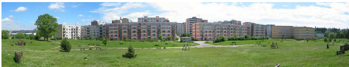
Obr.1 - Panoramatický pohled na Sídliště Libušín ve Žďáře nad Sázavou.
