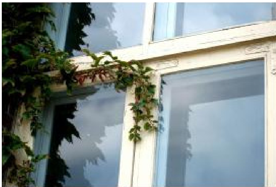
Obr. 8 Katastrofální stav výplní otvorů
