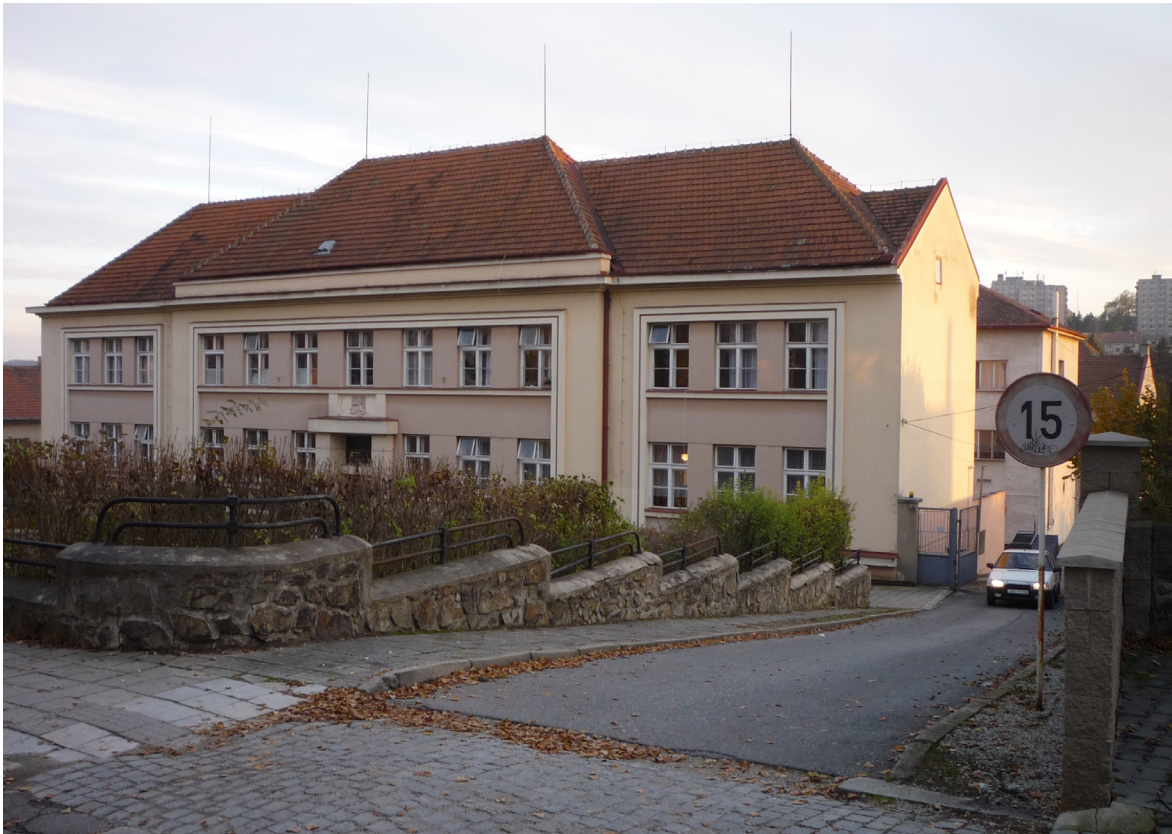
Obr. 9 Zpevněná příjezdová komunikace do areálu, severní křídlo budovy
