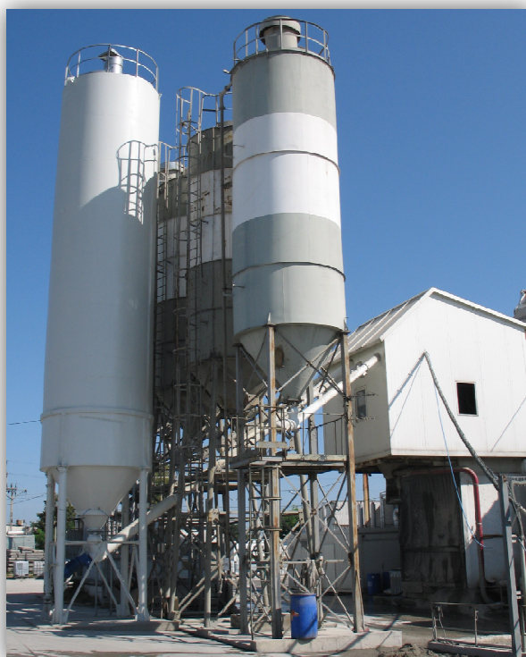
Obr. č. 25 Doplnění cementového hospodářství – celkový pohled
