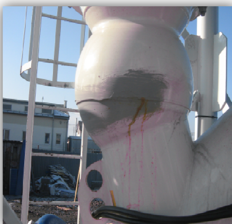
Obr. č. 35 Základní nátěr kloubové odbočky šnekového dopravníku
