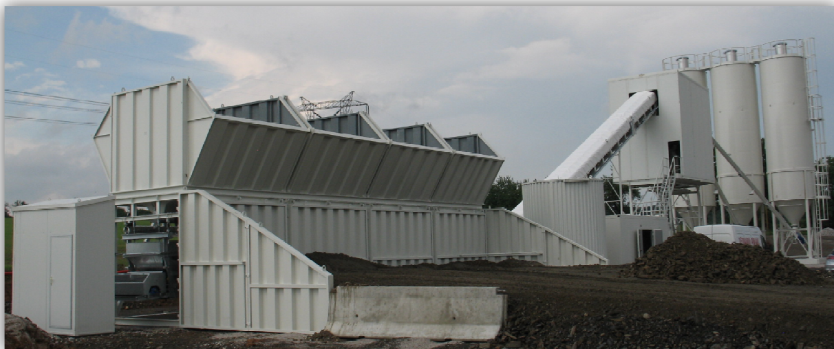
Obr. č. 9 Mobilní betonárna
