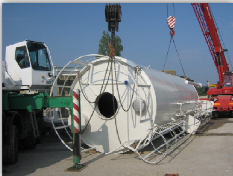
Obr. č. 28 Uchycení zvedacích prvků
