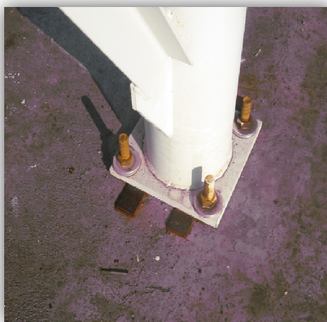
Obr. č. 31 Kotvení sila a vymešovací podložky
