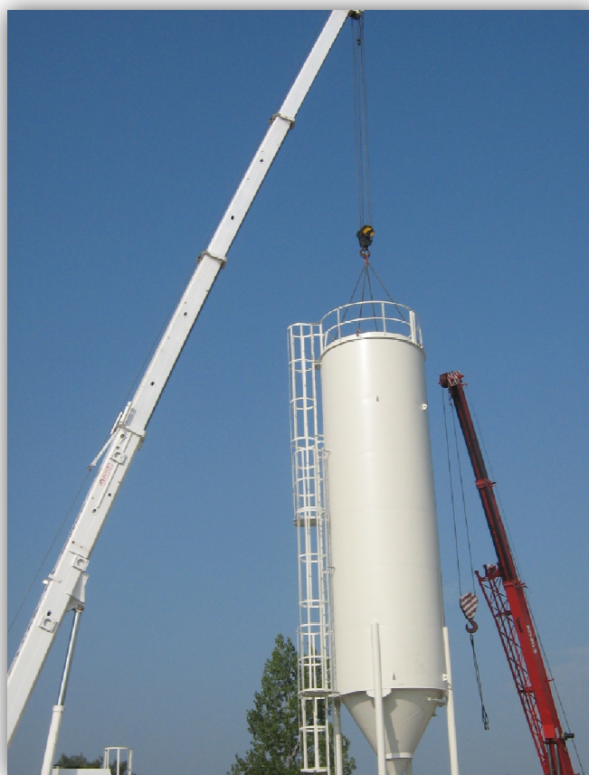
Obr. č. 29 Zvedání sil po instalaci žebříku, klapky a limitní sondy
