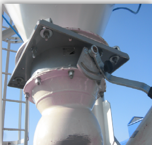
Obr. č. 34 Uchycení šnek. dopr. na podsilovou klapu
