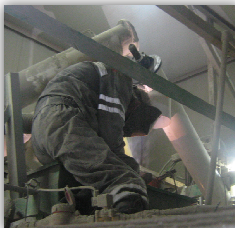
Obr. č. 41 Svařování příruby na váhu cementu
