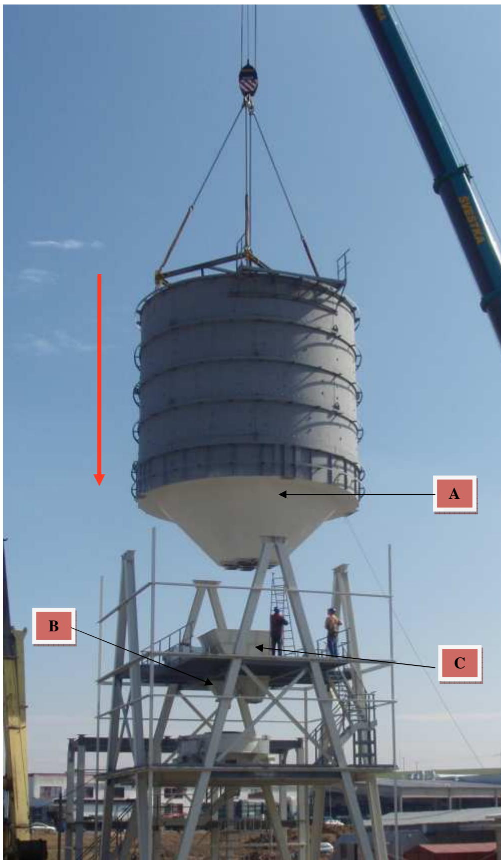
Obr. č. 16 Osazení zásobníku kameniva na nosnou konstrukci
