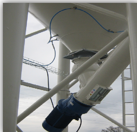
Obr. č. 37 Vrchní nátěr kloubové odbočky šnek.dopr.
