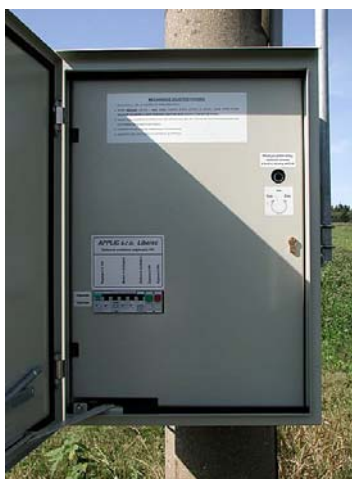
obr.3.15. skříň pro dálkový přenos měření
