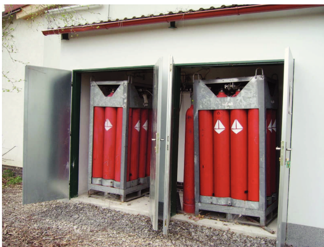
Obrázek 20: Sklad se dvěma svazky tlakových lahví
