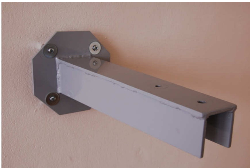
Obrázek 36 Konzole připevnění hlavice detektoru
