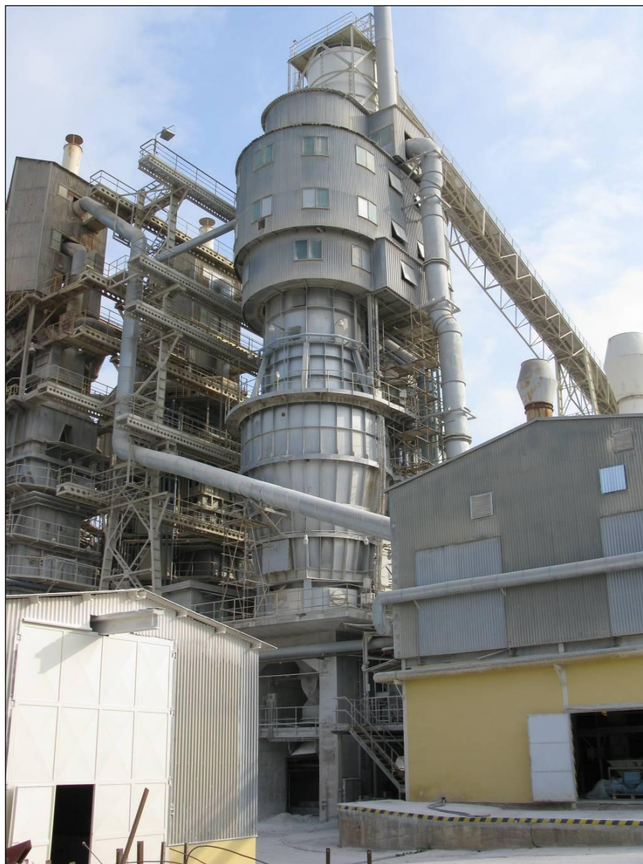
Obrázek č. 5 – Vápenka Vitošov s.r.o. - pece typu Maerz®
