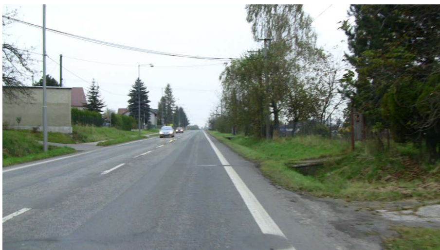
Foto. č. 5: Pohled na silnici II/470 směr Ostrava (km 7,500)
