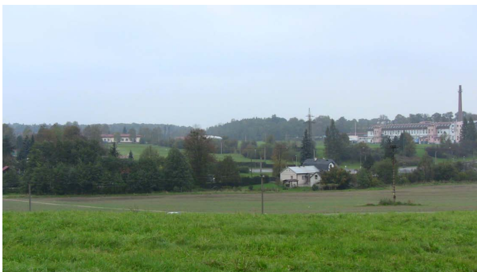
Foto. č. 3: Místo umístění MÚK Petřvald (km 9,500)
