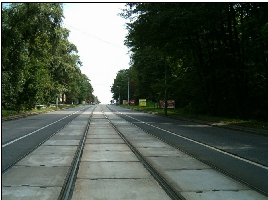
Obr.1: Tramvajová trať s krytem z betonových záďlažbových panelů (foto: Ing.L.Hudeček, Ph.D.)
