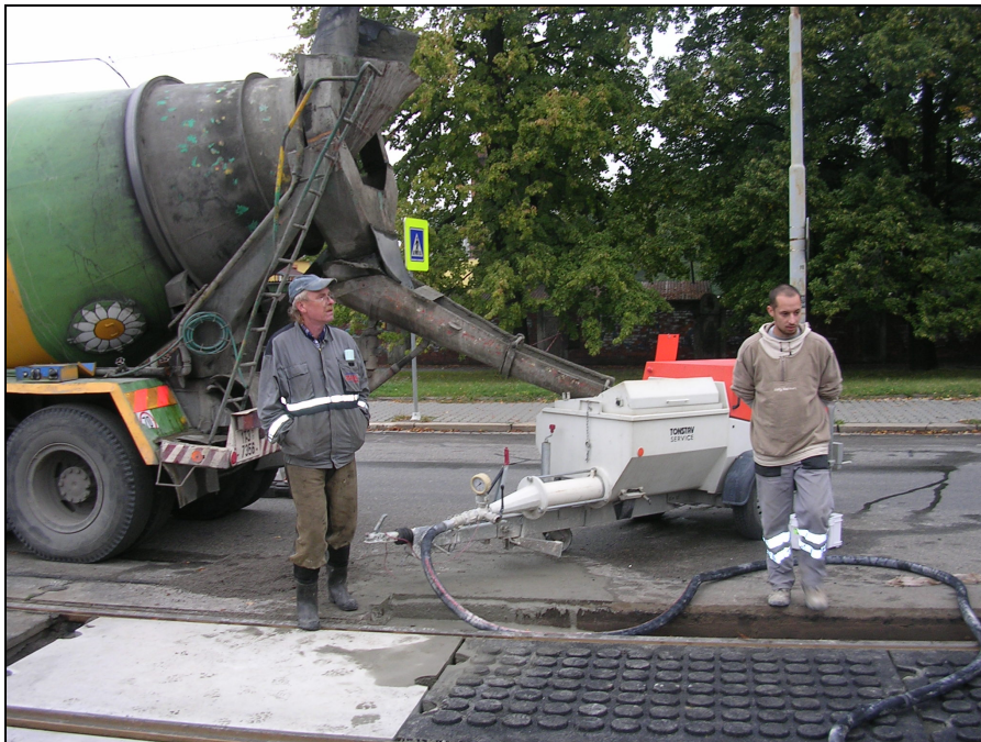
Obr. 3: Realizace zkušebního úseku tramvajové tratě (foto: archiv autora)
