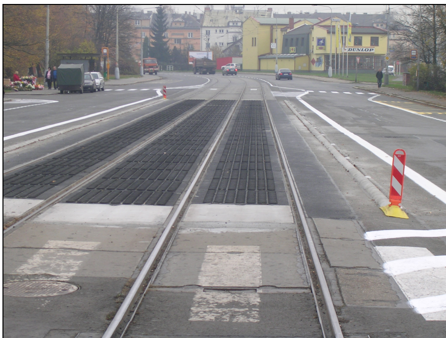
Obr.7: Zkušební úsek tramvajové tratě s upravenými panely na ul. Závodní v Ostravě-Hrabůvce (foto: archiv autora)
