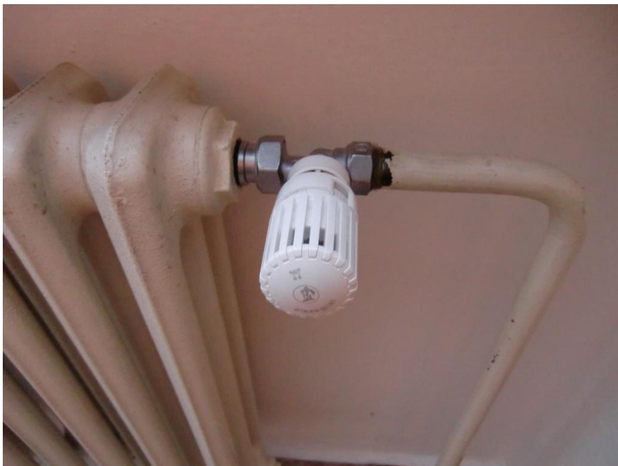
Obr. č. 6.9 Termoregulační ventil R432 TG firmy Giacomini
