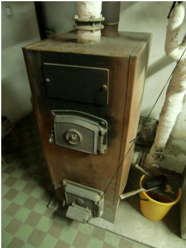
Obr. č. 6.7 Starý litinový kotel na tuhá paliva z roku 1983 blíže nespecifikovaných vlastností
