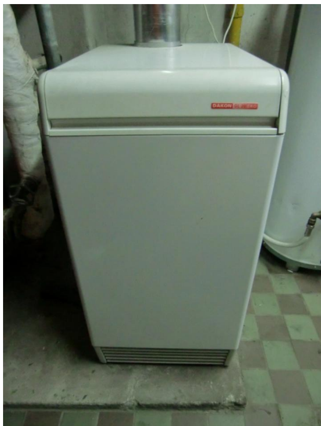
Obr. č. 6.6 Plynový stacionární kotel Dakon GL 20 Eko HL o výkonu 20/14 kW
