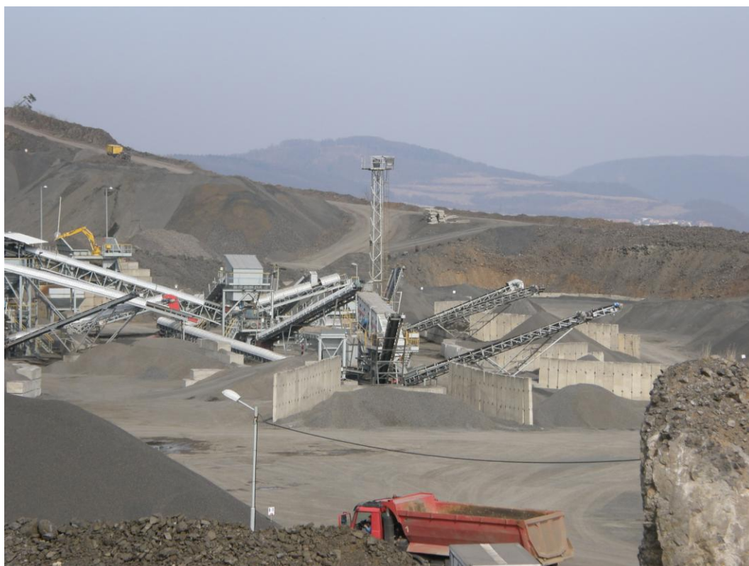
Obrázek č. 8: Strojní zařízení úpraven kameniva
