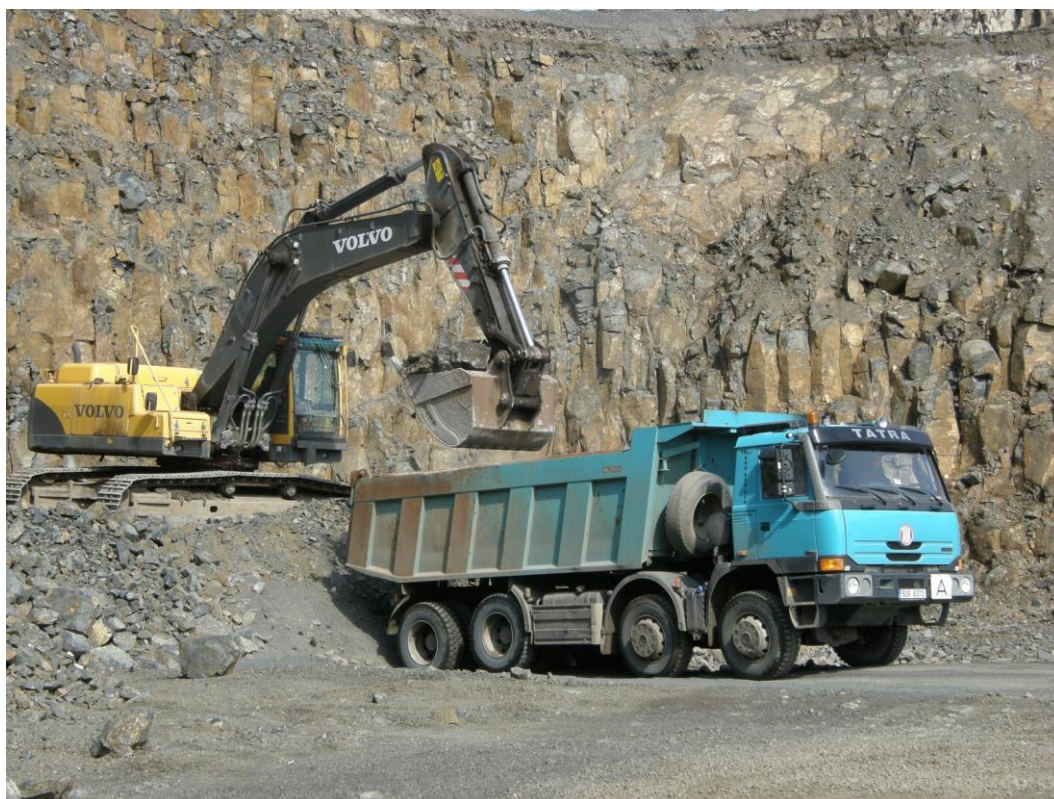
Obrázek č. 16: Technologická doprava rubaniny
