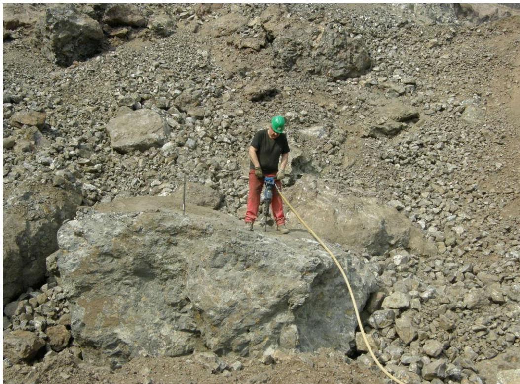
Obrázek č. 9: Vrtací práce pro budoucí TPMR
