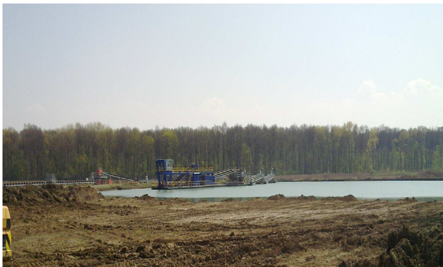
Obrázek č. 3 Korečkové rypadlo PKR 200
