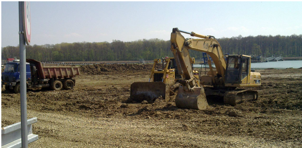
Obrázek č. 2 Technika k provádění skrývkových prací
