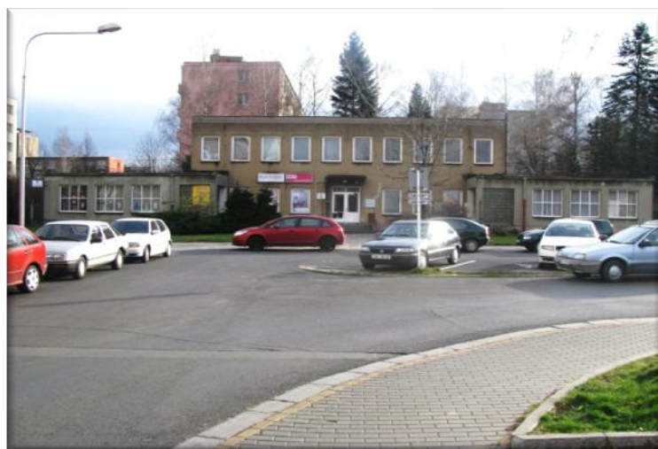
Obr. 2 Stávající stav objektu - Průčelí
